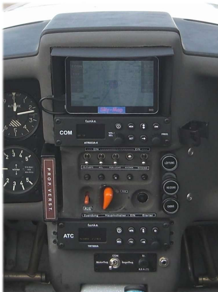
Abb.15 Einbau der Funk- und Funknavigationsgeräte und des GPS
